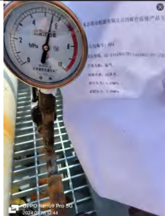
图 6-2 管道试压试验
