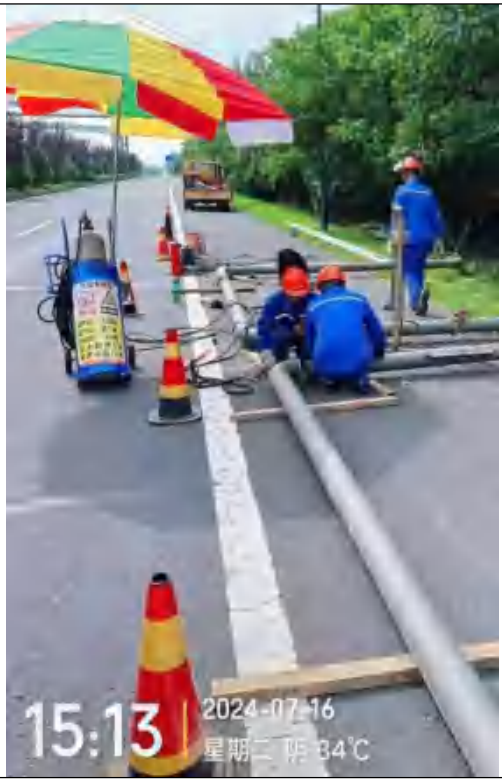
图 6-3 空旷地带进行焊接
