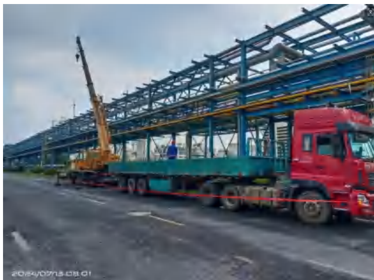
图 7-3 项目施工期管道运输
