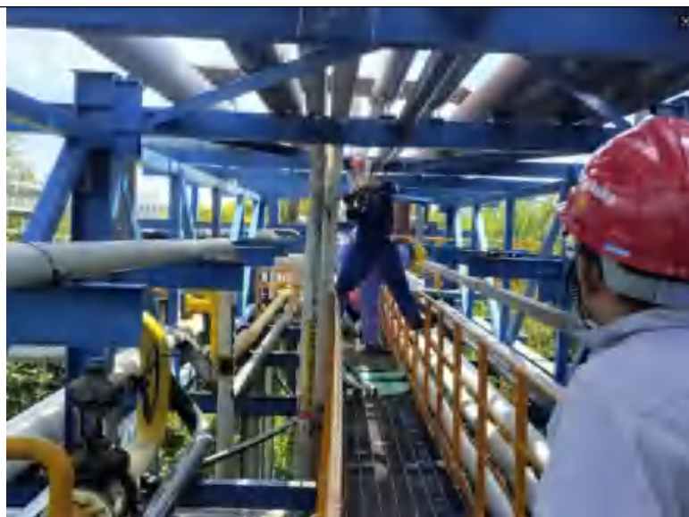
图 7-2 项目施工期选用低 VOCs 含量涂料喷涂
